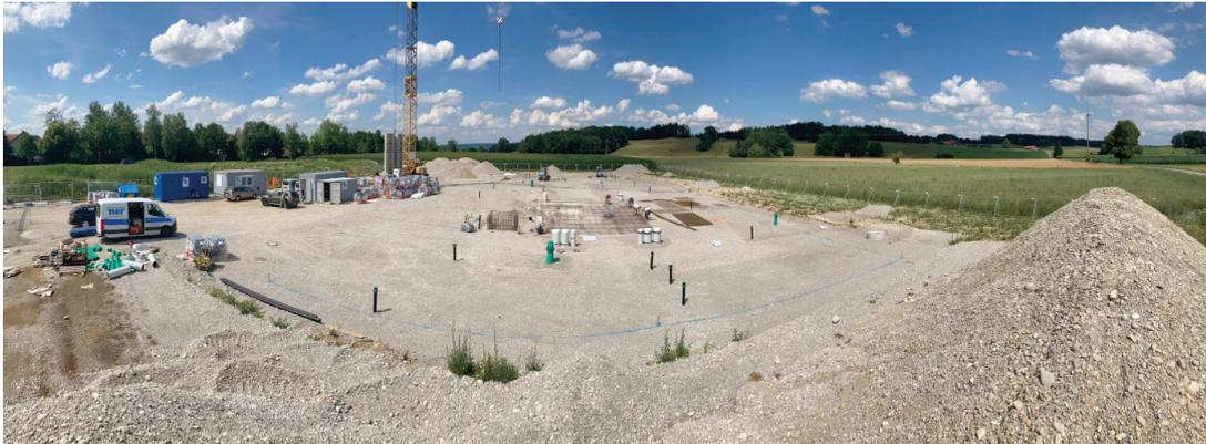
Das Baufeld wurde planiert, die Abwasserleitungen errichtet und anschließend die Grundleitungen unter der späteren Bodenplatte verlegt.
